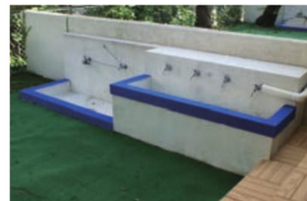
施工例：水飲み場枠
