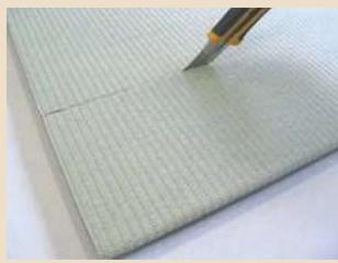
①浴室の形状に合わせカッター等により畳を裁断します。なるべく裁断面が壁側、浴槽壁面になるようにしてください。
